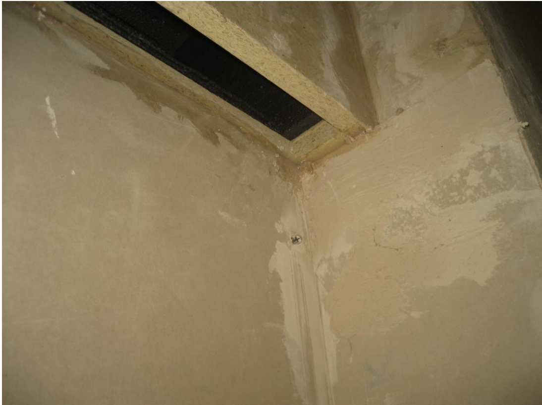
Bild 5: Muster – Rollladenkasten aus Holzpressplatten, Detail, 13 mm Roka - Thermo - Flex
