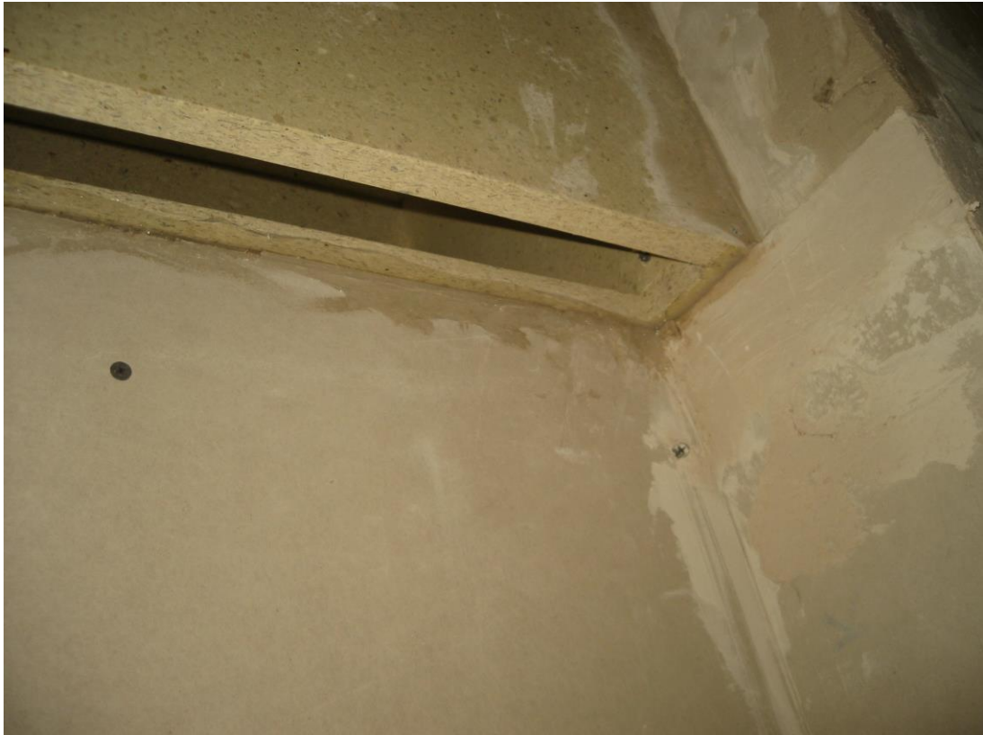
Bild 3: Muster – Rollladenkasten aus Holzpressplatten, Detail, leerer Kasten
