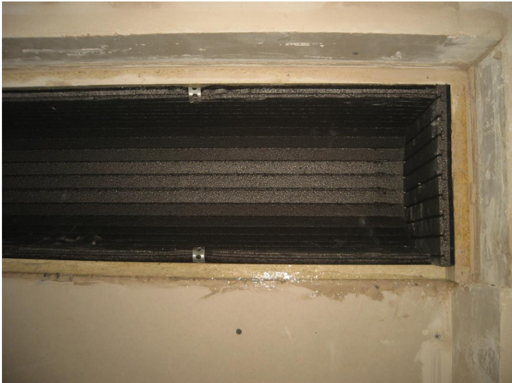
Bild 9: Muster – Rollladenkasten aus Holzpressplatten, Detail, 13 mm Roka - Thermo - Flex im Verbund mit 5 mm Gummischrotplatte
