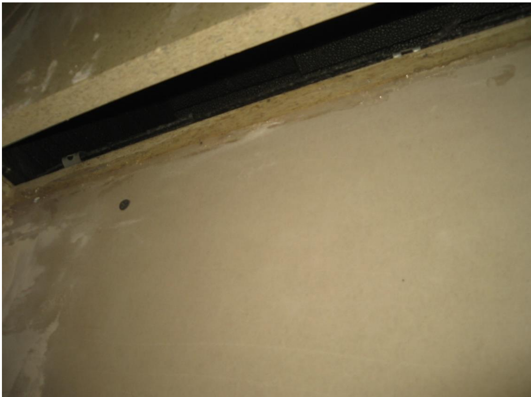
Bild 6: Muster – Rollladenkasten aus Holzpressplatten, Detail, 13 mm Roka - Thermo - Flex
