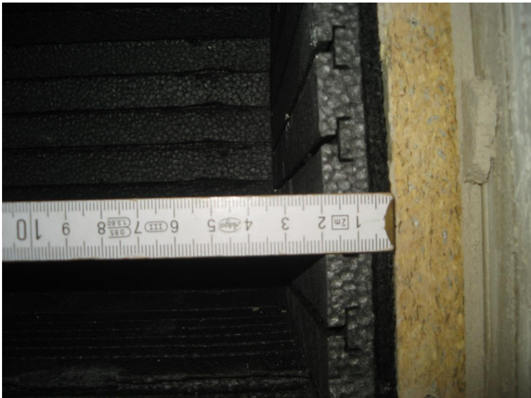
Bild 10: Muster – Rollladenkasten aus Holzpressplatten, Detail, 13 mm Roka - Thermo - Flex im Verbund mit 5 mm Gummischrotplatte
