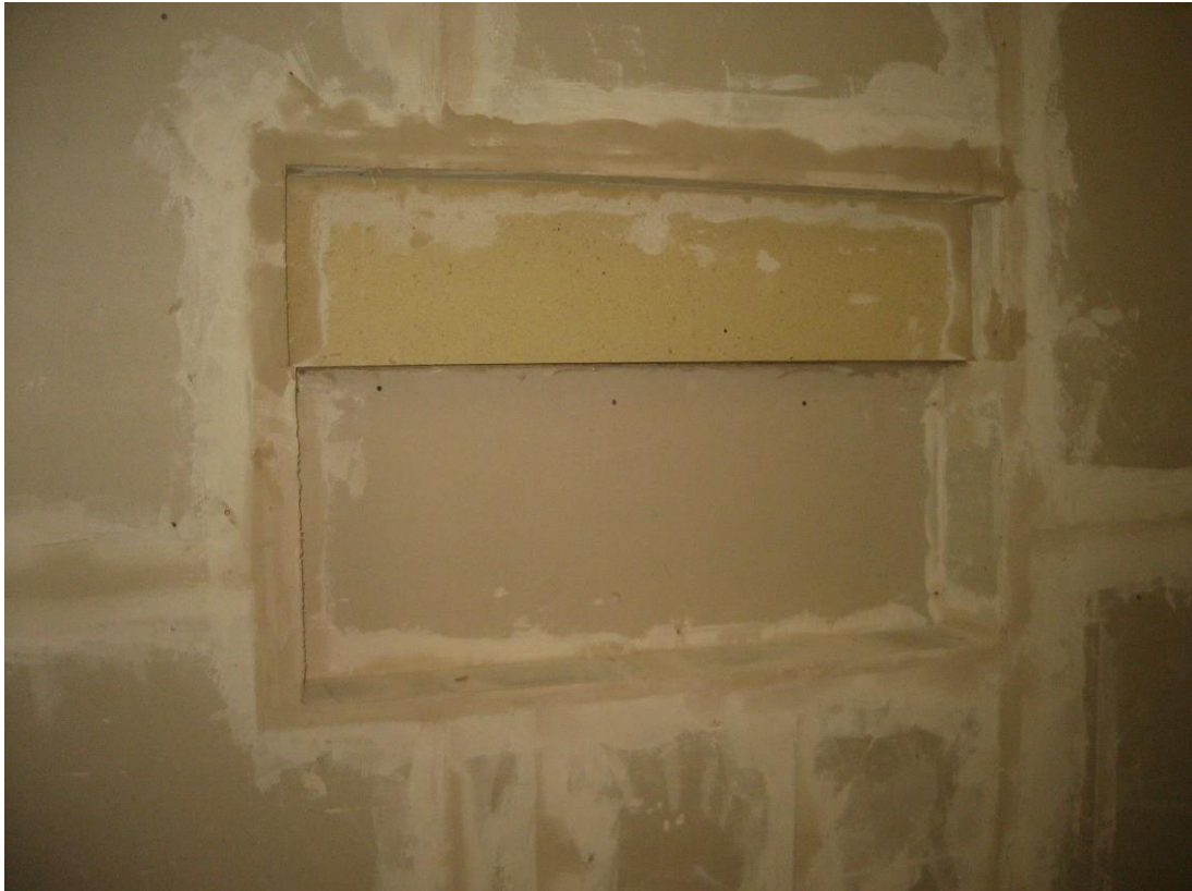
Bild 1: Muster – Rollladenkasten aus Holzpressplatten, Ansicht, Senderraum
