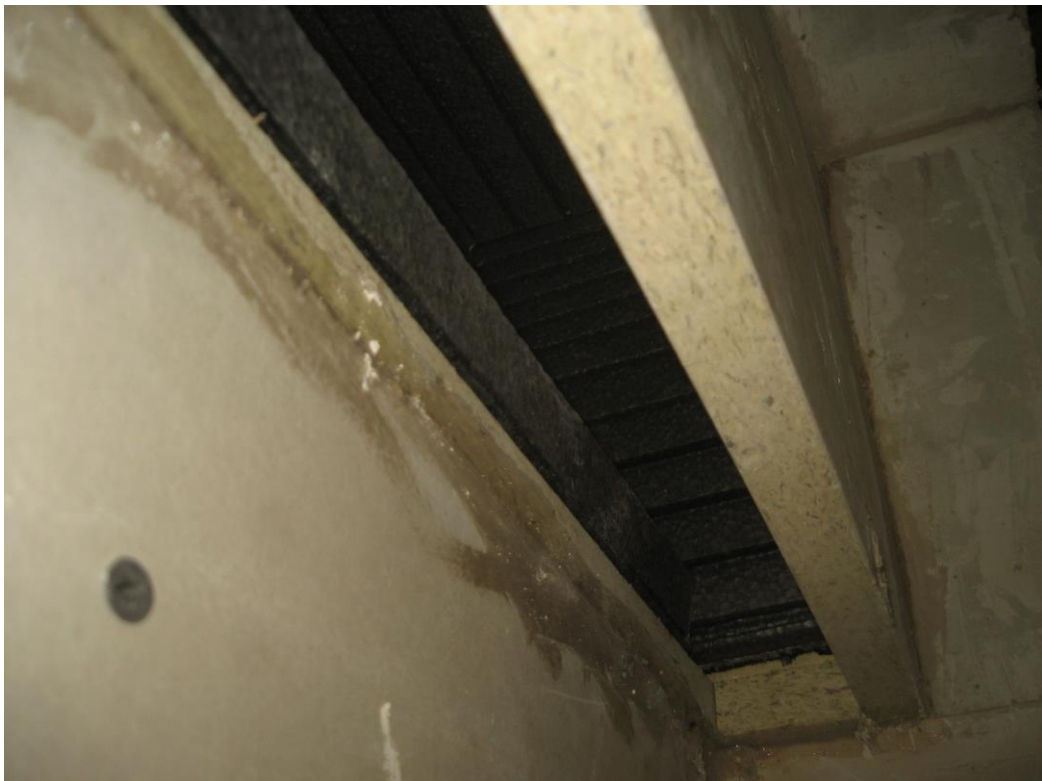
Bild 12: Muster – Rollladenkasten aus Holzpressplatten, Detail, 25 mm Roka - Thermo - Flex im Verbund mit 5 mm Gummischrotplatte
