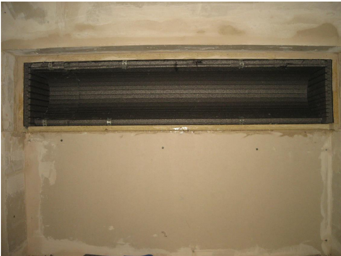
Bild 8: Muster – Rollladenkasten aus Holzpressplatten, Detail, 25 mm Roka - Thermo - Flex
