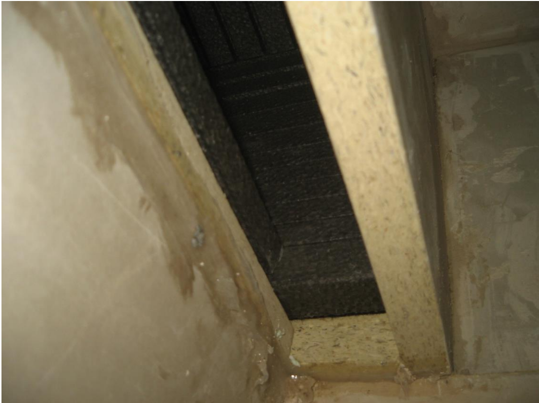
Bild 7: Muster – Rollladenkasten aus Holzpressplatten, Detail, 25 mm Roka - Thermo - Flex
