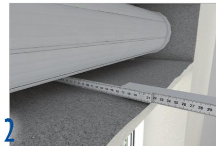
2 Misurare il vano interno del cassonetto per determinare la lunghezza e lo spessore dei pannelli isolanti.
