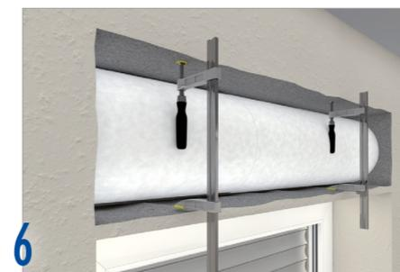
6 Fissare l'isolamento (utilizzare un morsetto).
