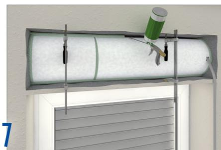
7 Fissare e sigillare i pannelli isolanti con schiuma per montaggio alla battuta e nelle zone di giunzione.
