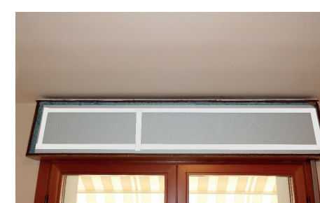
Q RIPOSIZIONARE IL PANNELLO FRONTALE E SIGILLARE TRAMITE NASTRO
