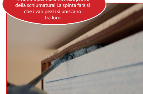
N INSERIRE IL PANNELLO FRONTALE DAL LATO CON L'INCAVO; SCHIUMARE LO SPAZIO TRA CASSONETTO E PROFILI 1, 2, 3, 4
