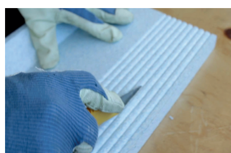
E SAGOMARE I PROFILI IN BASE ALLE MISURE
