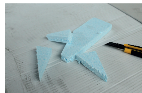
L CON GLI SCARTI RIMASTI FORMARE DEI CUNEI DA INSERIRE TRA AVVOLGIBILE E I PROFILI
