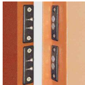
Doppi contatti elettrici tra anta e telaio
