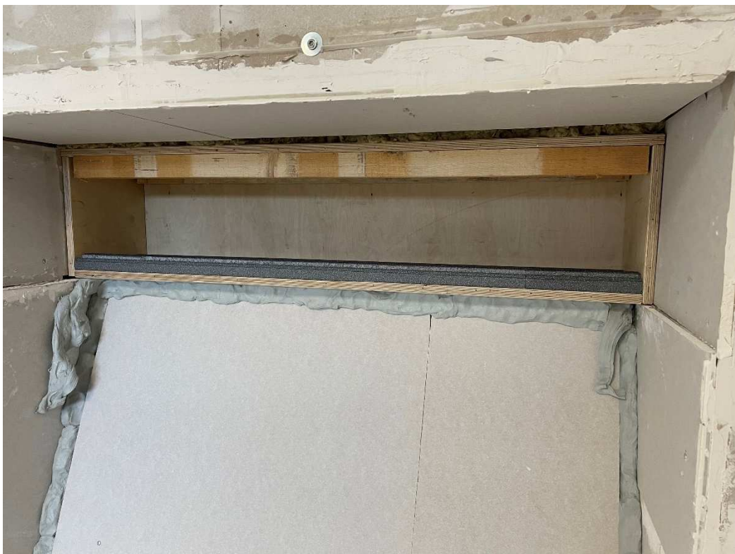
Bild 2: Multiplex Mehrschichtplatten- Kasten SAN Flex - Verschlussdeckeldämmung aus Neopor
