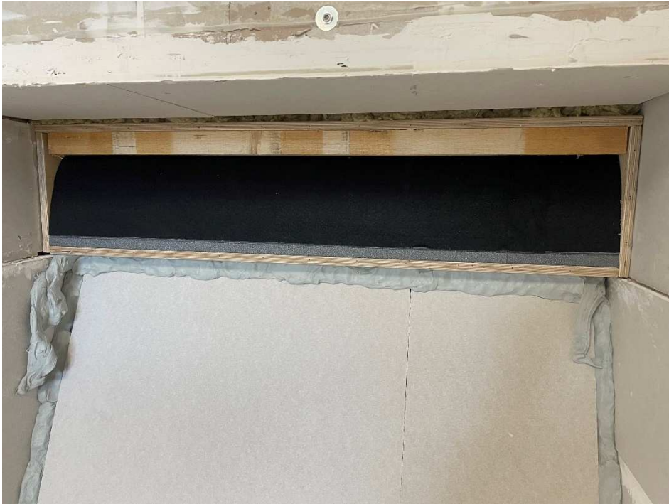
Bild 8: Nahaufnahme des Einbaus mit SAN- Flex Dämmplatte & Verschlussdeckeldämmung
