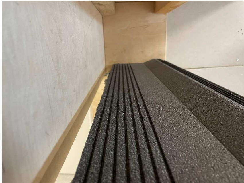
Bild 5: Multiplex Mehrschichtplatten- Kasten – Innenansicht mit Verschlussdeckeldämmung
