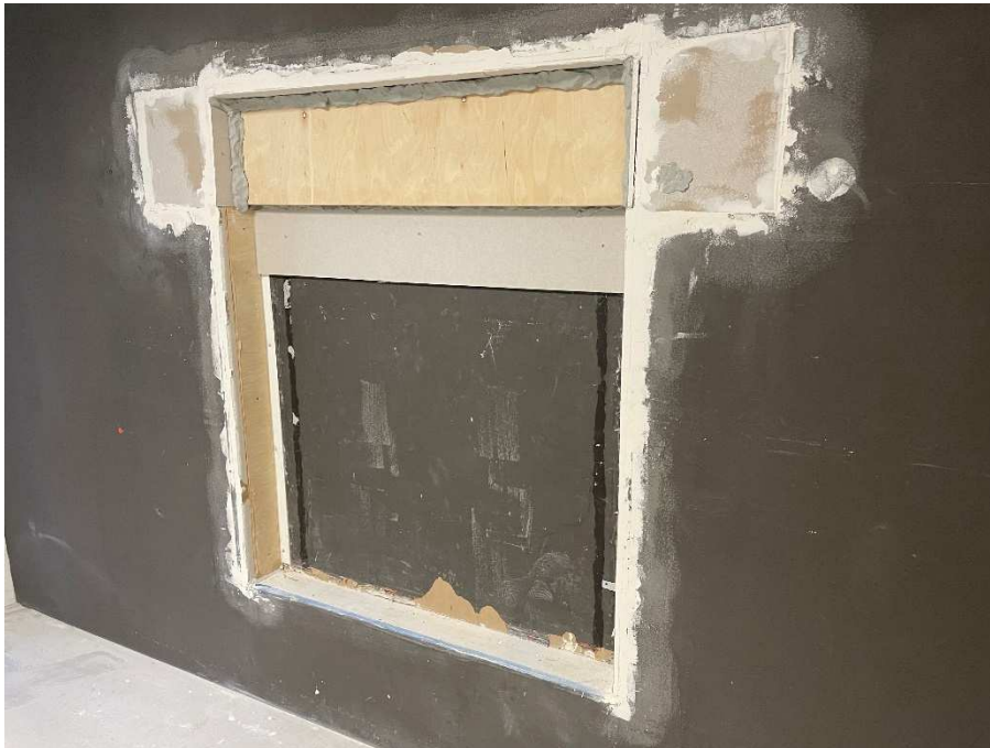
Bild 3: Multiplex Mehrschichtplatten- Kasten, Ansicht Senderaum
