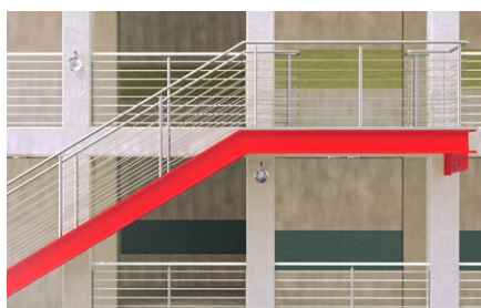
Carpenteria metallica pesante.
